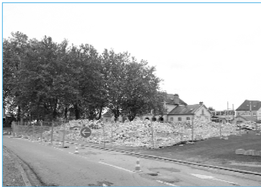
Le chantier de l'intermodalité : de gros travaux sont engagés gare de La Souterraine pour améliorer l'intermodalité train-auto-piétons. Seront ils dédiés à une gare sans trains ni voyageurs ?
